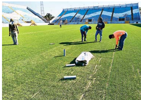
La semana anterior se atendió de forma manual pequeños desperfectos en el cosido de la grama.
